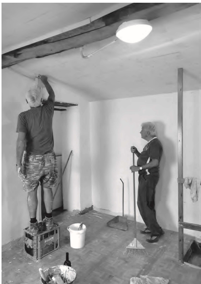
Giugno 2018: lavori alla Baita
